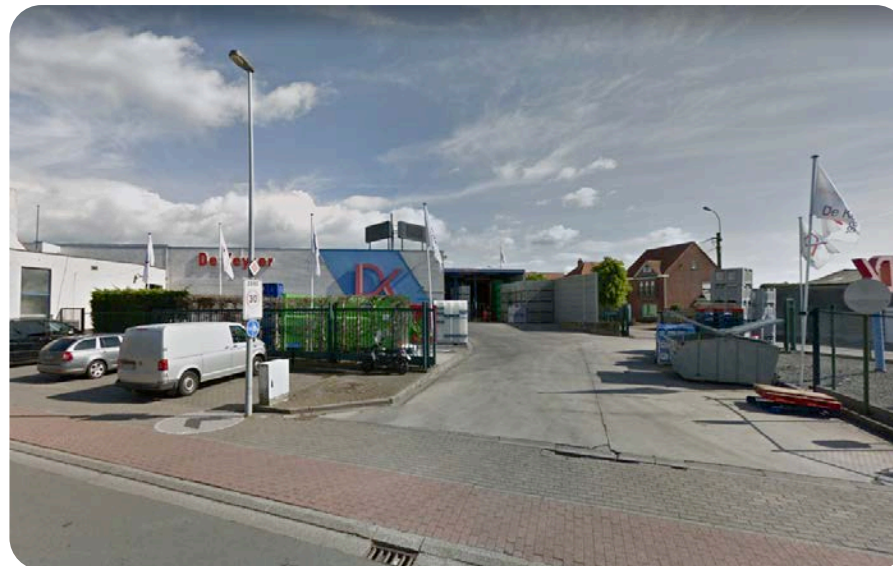
De Keyser, met ingang aan de zijde van de Rozestraat
