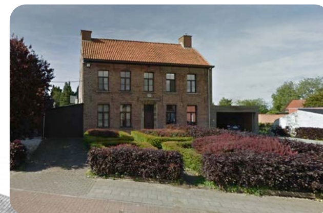
Herenhuis, foto 2020, rechts nieuw aangebouwde garage
