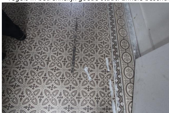
Detail vloer met cementtegels H1-5 (tweede deel)
