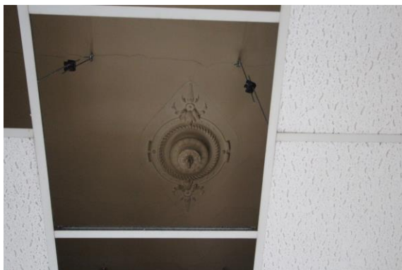
Verwijderde plafondtegels trapportaal H1-4
