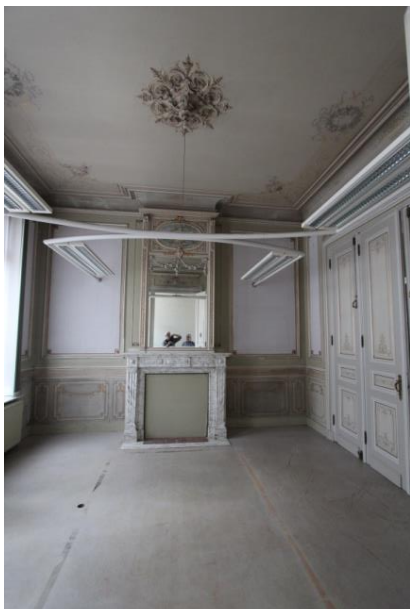
Plafond, holrand en lijsten in polychromie kamer H1-1
