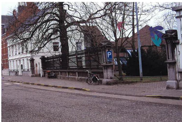
©foto's studie Carlier 2003 - voormalig hekwerk tussen n°29 en n° 31
