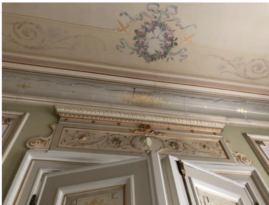
Plafond, holrand en lijsten in polychromie kamer H1-1
