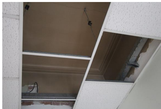
Verwijderde plafondtegels trapportaal H1-4
