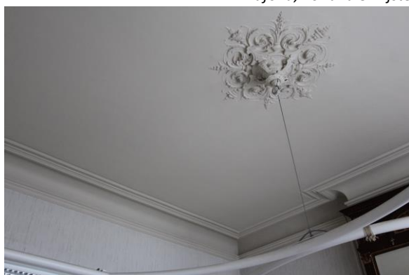
Plafond: Enkel lijstwerk en een rosas kamer H1-2
