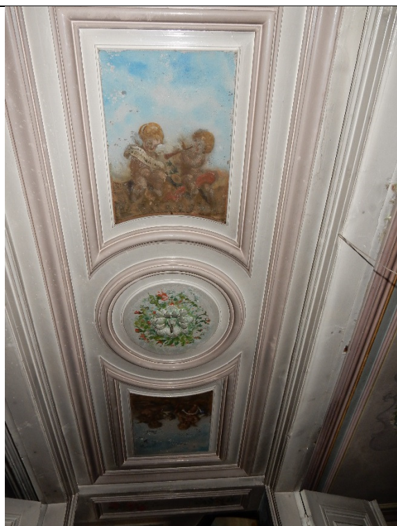
Plafond in voorste deel
