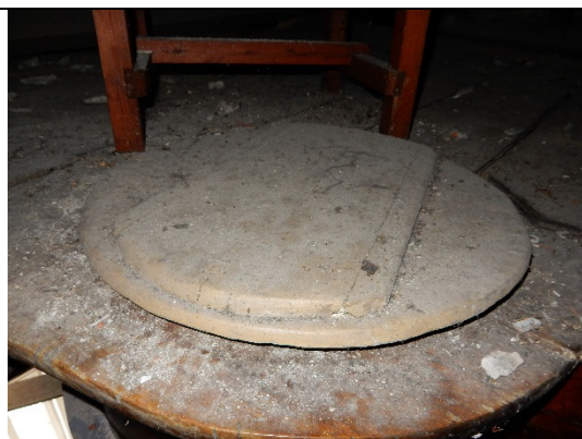
Deksel in vloer mezzanine
