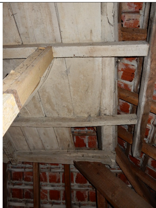
Vloer van mezzanine
