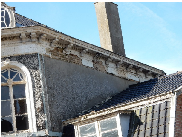
Lijst: pleister weg Rotsbepleistering: in blazen
