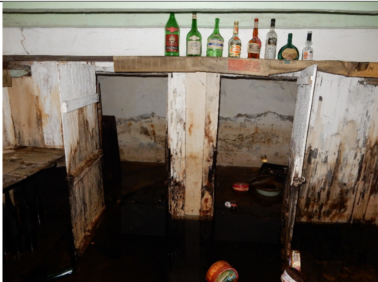
deuren aan nissen
