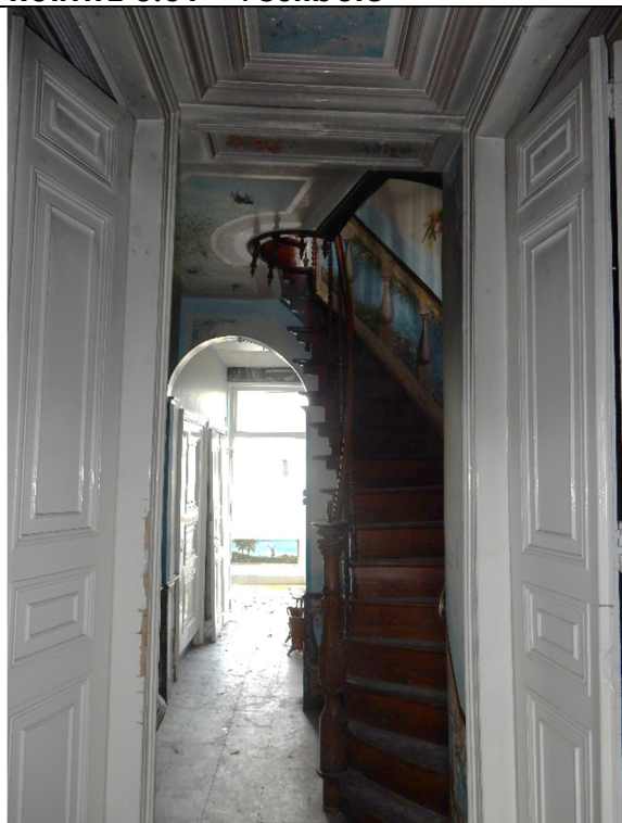
Zicht vanaf voordeur D0.01
