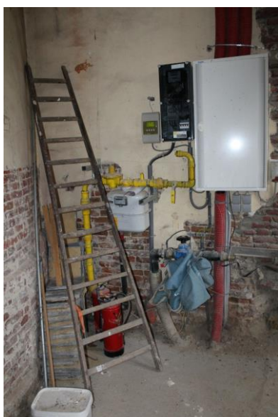
Vooraf in de onderbouw van de wanden werd pleisterwerk verwijderd. Hier foto van sacristie met gasleiding en elektriciteitskast.
