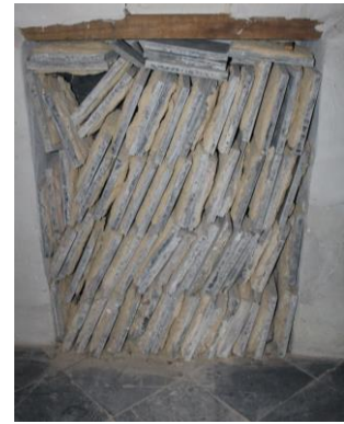
De vloertegels (imitaties van Maaskalkstenen?) van de sacristie werden uitgebroken en gestapeld achter het hoofdaltaar.
