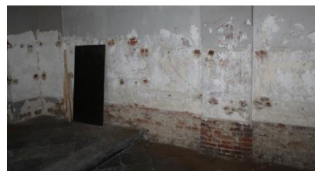
Ook de lambriseringen in het koor werden verwijderd. De muren lijken ondertussen uitgedroogd. Het is niet duidelijk of er injecties, om opstijgend vocht tegen te gaan, werden uitgevoerd.
