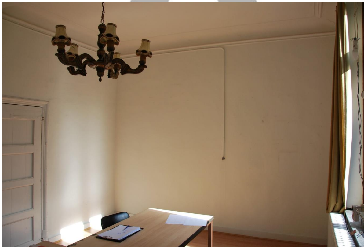
Situering: Koersel | Pastorie. Beschrijving: Interieur | Nivo 1 | Ruimte 1.4. Bron: Architectenburo Erik Martens & Partners | 2019.
