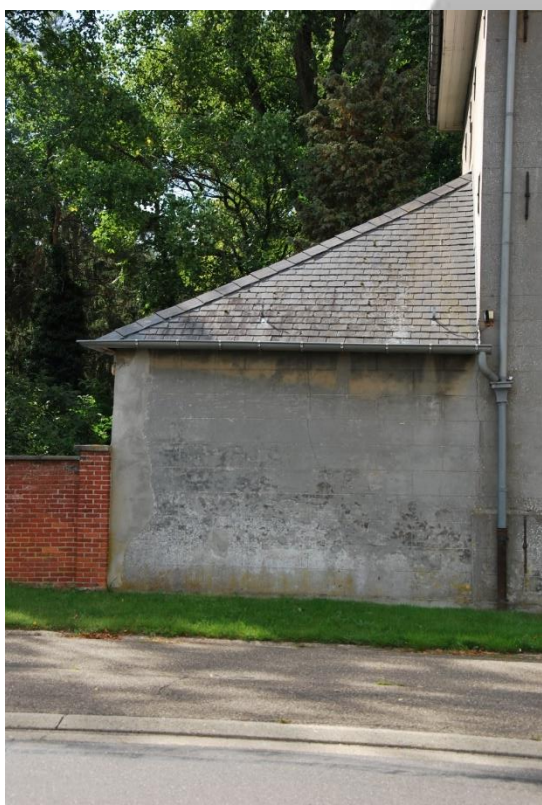
Situering: Koersel | Pastorie. Beschrijving: Extérieur | Voorgevel (detail gevel). Bron: Architectenburo Erik Martens & Partners | 2019.
