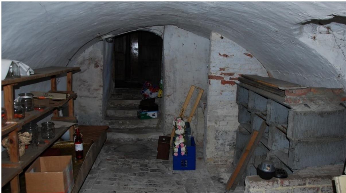
Situering: Koersel | Pastorie. Beschrijving: Interieur | Nivo -1 | Ruimte -1.1. Bron: Architectenburo Erik Martens & Partners | 2019.
