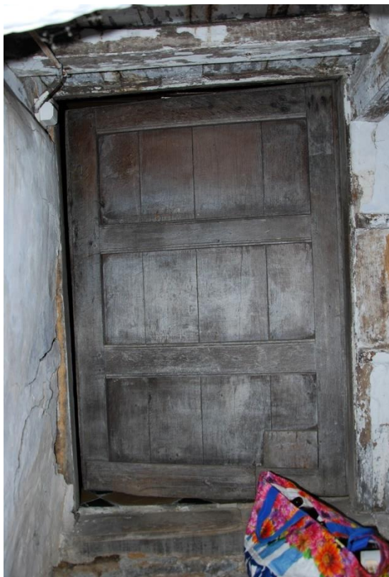
Situering: Koersel I Pastorie. Beschrijving: Interieur I Nivo -1 I Ruimte -1.1. Bron: Architectenburo Erik Martens & Partners I 2019.
