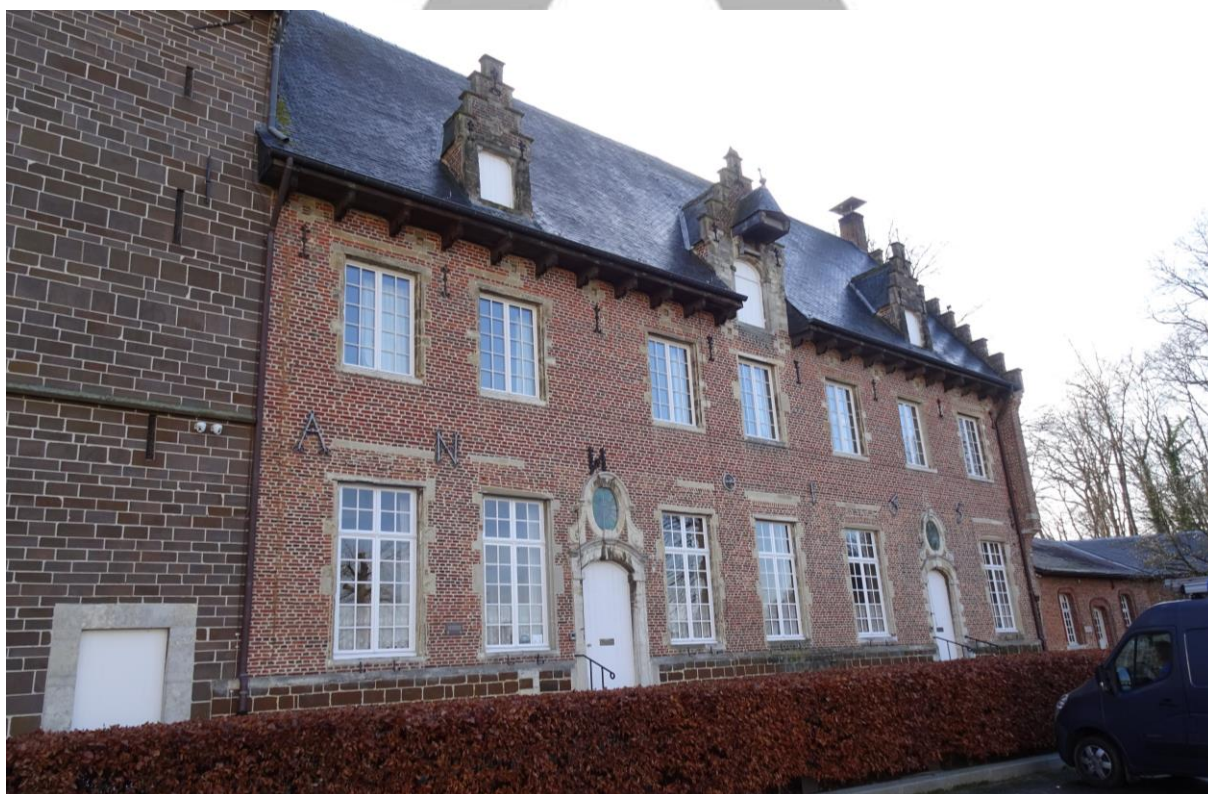
Situering: Abdij van Averbode | Huis van de provisor. Beschrijving: Traditionele bak-en zandsteenstijl | Datering 1651 | Referentievoorbeeld van een gebouw uit dezelfde bouwtijd. Bron: Foto Liz Dewitte, 10/12/2019.
