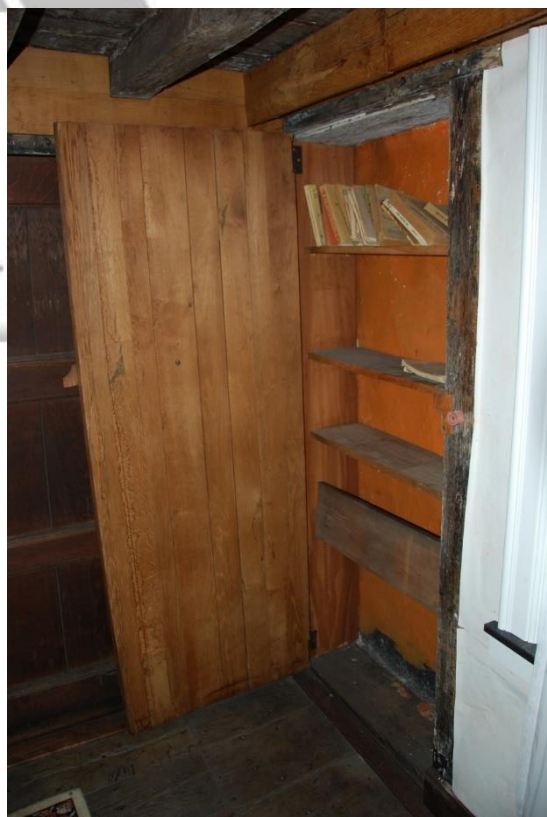
Situering: Koersel I Pastorie. Beschrijving: Interieur I Nivo 1 I Ruimte 1.9. Bron: Architectenburo Erik Martens & Partners I 2019.
