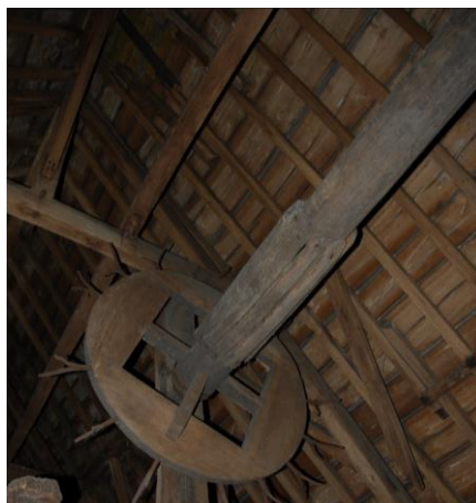
Interieur | Nivo 2 | Ruimte 2.1 | Hijssrad op de tienden zolder.
