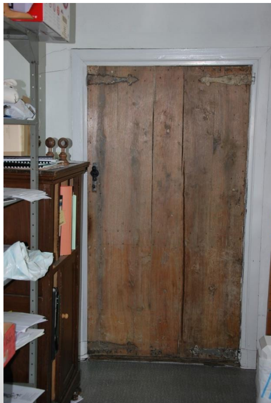
Situering: Koersel I Pastorie. Beschrijving: Interieur I Nivo 0 I Ruimte 0.5. Bron: Architectenburo Erik Martens & Partners I 2019.
