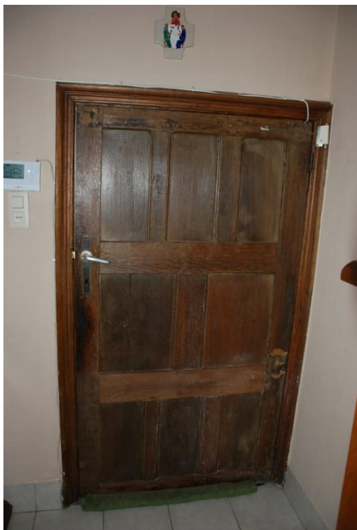
Situering: Koersel | Pastorie. Beschrijving: Interieur | Nivo 0 | Ruimte 0.4. Bron: Architectenburo Erik Martens & Partners | 2019.
