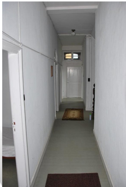
Situering: Koersel I Pastorie. Beschrijving: Interieur I Nivo 1 I Ruimte 1.1. Bron: Architectenburo Erik Martens & Partners I 2019.
