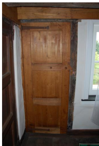
Interieur | Nivo 1,5 | Ruimte 1.9 | Ingewerkte deur in buitengevel.
