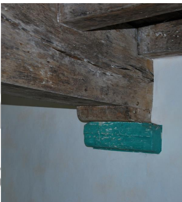
Interieur | Nivo 1,5 | Ruimte 1.9 | Moerbalk met sleutelstuk.
