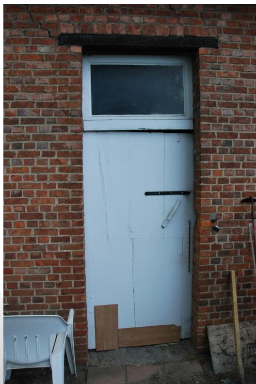
Situering: Koersel I Pastorie. Beschrijving: Interieur I Nivo 0 I Ruimte 0.12. Bron: Architectenburo Erik Martens & Partners I 2019.
