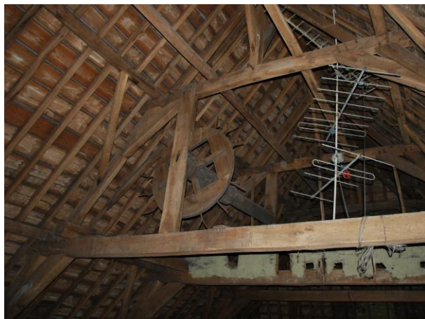
Interieur | Nivo 2 | Ruimte 2.1 | Tienden zolder.
