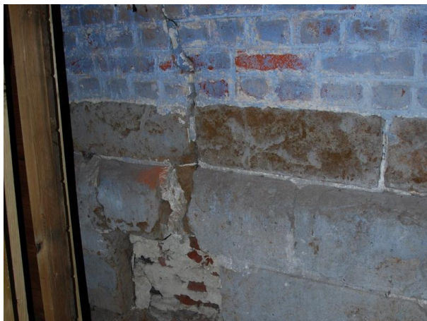
Interieur | Ruimte 0.12 | Plint uit ijzerzandsteen (bovenste deel).
