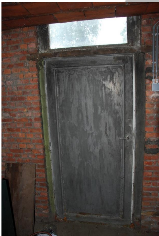
Situering: Koersel I Pastorie. Beschrijving: Interieur I Nivo 0 I Ruimte 0.13. Bron: Architectenburo Erik Martens & Partners I 2019.
