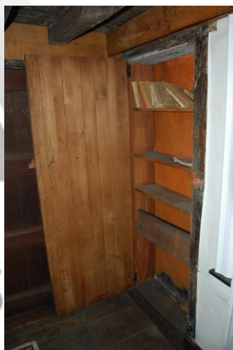
Interieur | Nivo 1,5 | Ruimte 1.9 | Ingewerkte deur in buitengevel.
