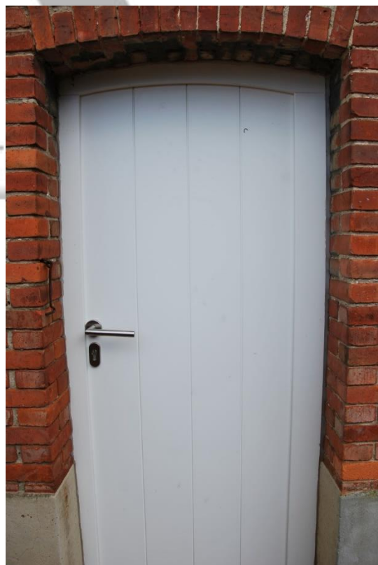
Situering: Koersel I Pastorie. Beschrijving: Interieur I Nivo 0 I Ruimte 0.8. Bron: Architectenburo Erik Martens & Partners I 2019.
