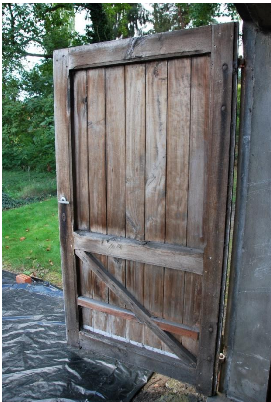
Situering: Koersel I Pastorie. Beschrijving: Interieur I Nivo 0 I Ruimte 0.15. Bron: Architectenburo Erik Martens & Partners I 2019.
