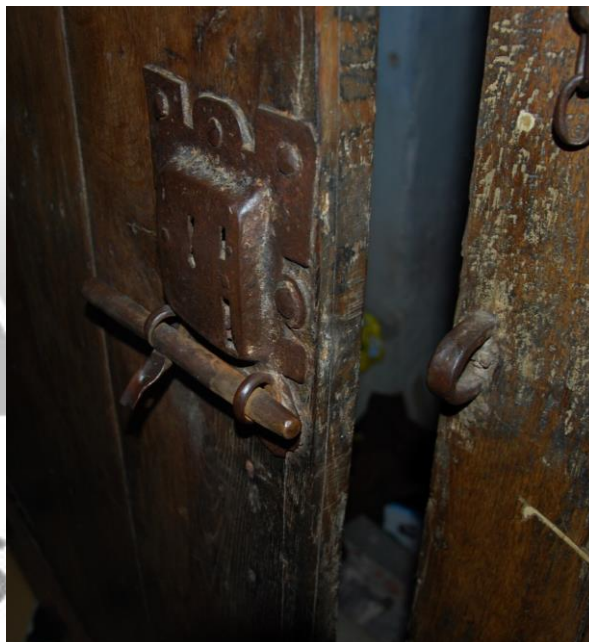
Interieur | Ruimte 0.1 | Deur naar kelder onder de trap.
