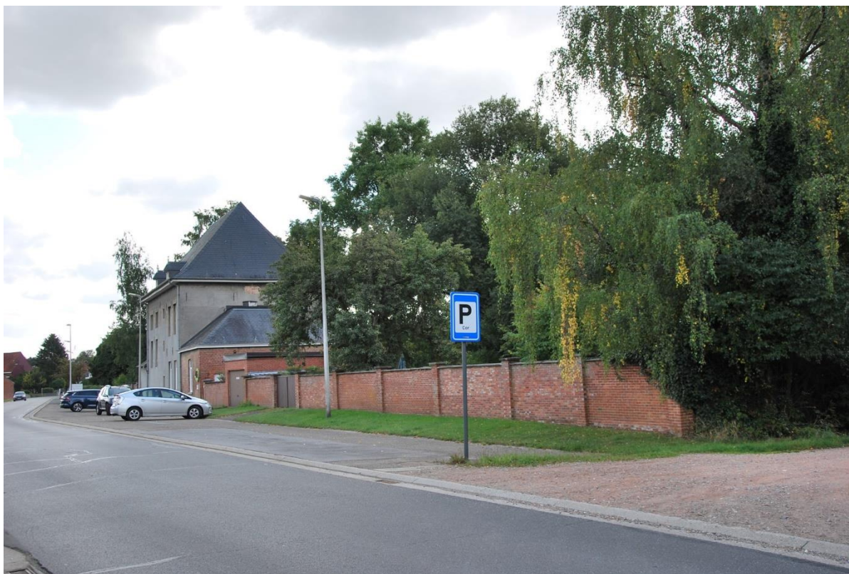
Situering: Koersel | Pastorie. Beschrijving: Tuinmuur | Zicht vanaf de Pastorijstraat. Bron: Architectenburo Erik Martens & Partners | 2019.
