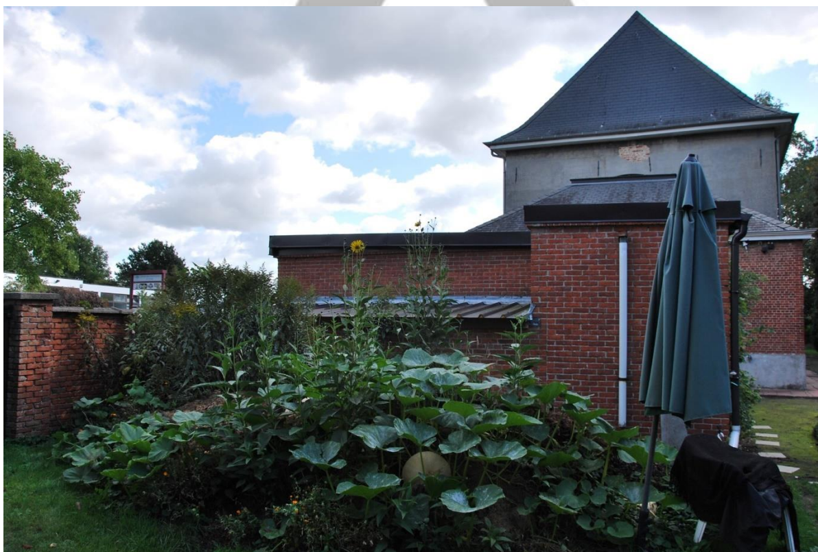
Situering: Koersel | Pastorie. Beschrijving: Extérieur | Zijgevel links (zicht vanaf de tuin). Bron: Architectenburo Erik Martens & Partners | 2019.
