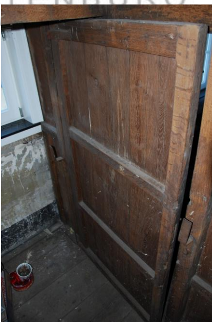
Interieur | Nivo 2 | Toegangsdeur naar de tienden zolder.
