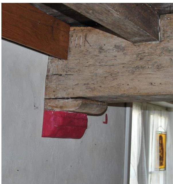
Interieur | Nivo 1,5 | Ruimte 1.9 | Moerbalk met sleutelstuk en telmerk.
