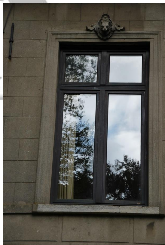
Situering: Koersel I Pastorie. Beschrijving: Extérieur I Voorgevel (detail buitenschrijnwerk). Bron: Architectenburo Erik Martens & Partners I 2019.
