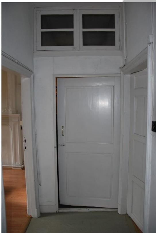
Situering: Koersel I Pastorie. Beschrijving: Interieur I Nivo 1 | Ruimte 1.3. Bron: Architectenburo Erik Martens & Partners | 2019.
