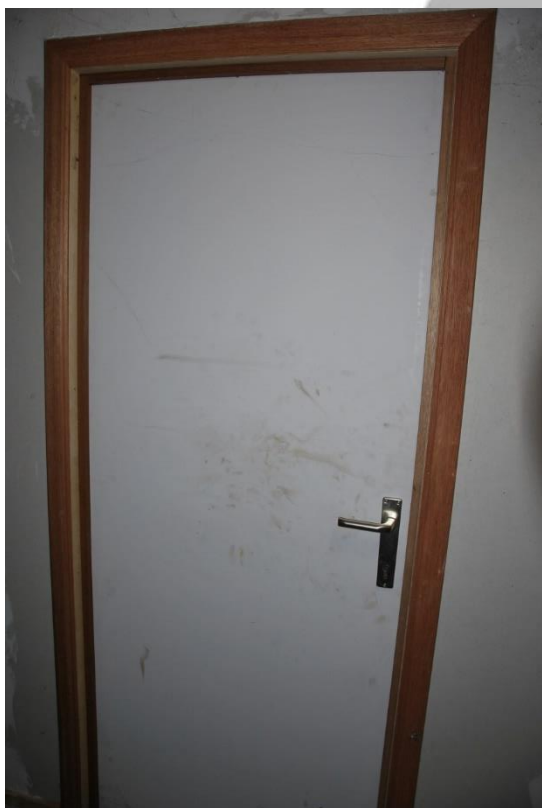
Situering: Koersel I Pastorie. Beschrijving: Interieur I Nivo 0 I Ruimte 0.14. Bron: Architectenburo Erik Martens & Partners I 2019.
