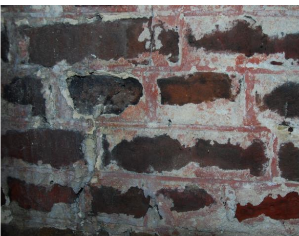
Interieur I Ruimte 0.14 I Restanten van kleurlaag I Dagstreep en knipvoeg.
