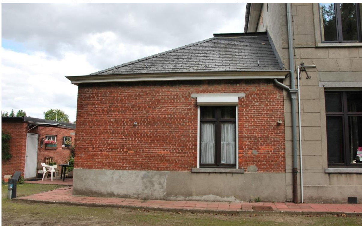
Situering: Koersel I Pastorie. Beschrijving: Extérieur I Voorgevel (detail gevel). Bron: Architectenburo Erik Martens & Partners I 2019.
