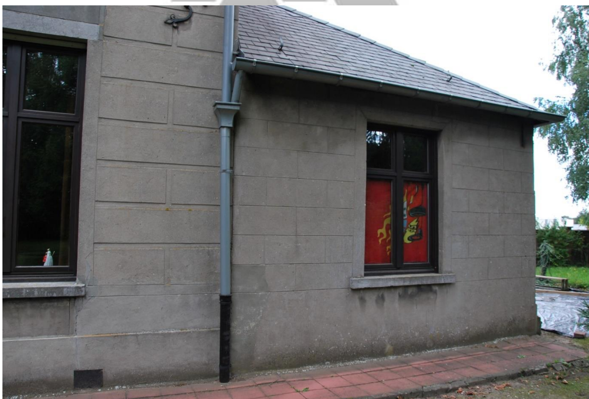
Situering: Koersel | Pastorie. Beschrijving: Extérieur | Voorgevel (detail gevel). Bron: Architectenburo Erik Martens & Partners | 2019.
