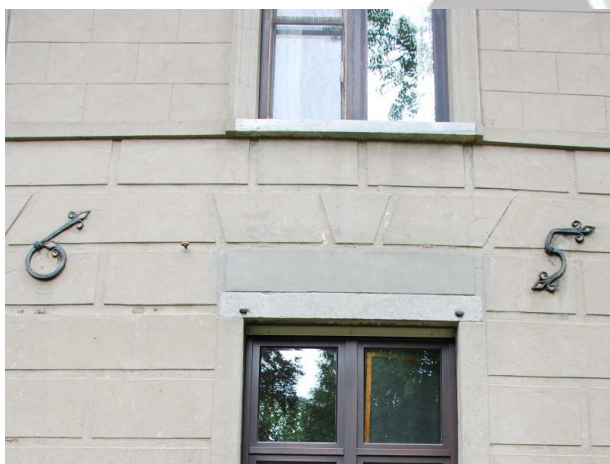
Voorgevel I Muurankers anno 1655.
