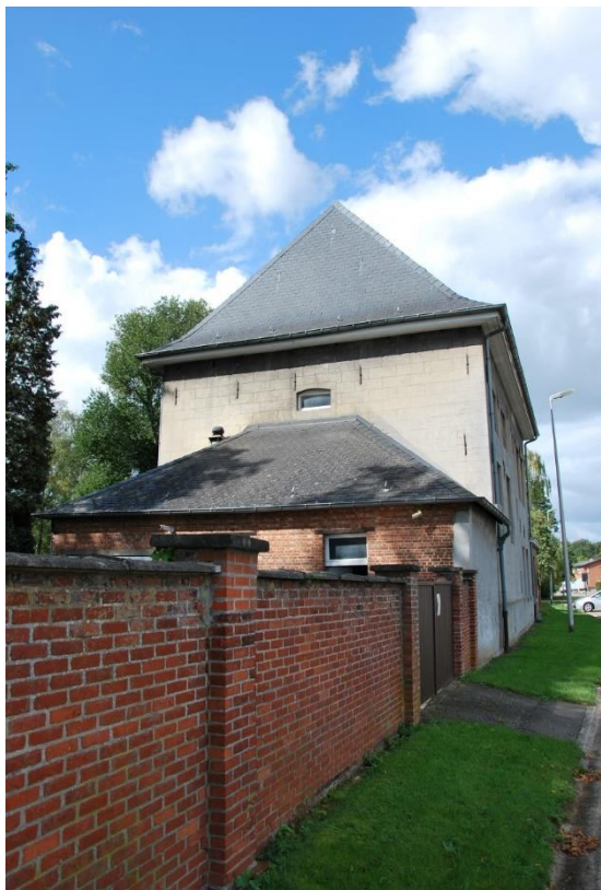
Situering: Koersel I Pastorie. Beschrijving: Extérieur I Zijgevel rechts (zicht vanaf de Pastorijstraat). Bron: Architectenburo Erik Martens & Partners I 2019.
