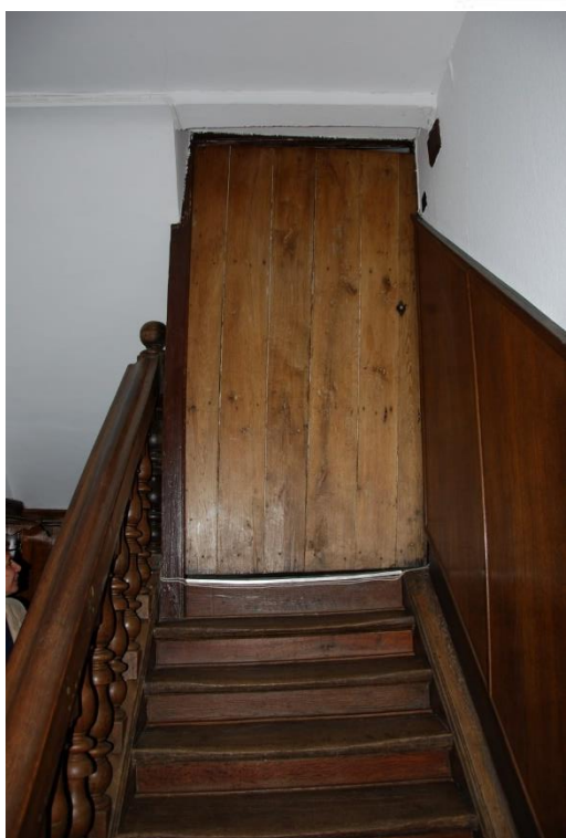
Situering: Koersel I Pastorie. Beschrijving: Interieur I Nivo 0 I Ruimte 0.1. Bron: Architectenburo Erik Martens & Partners I 2019.
