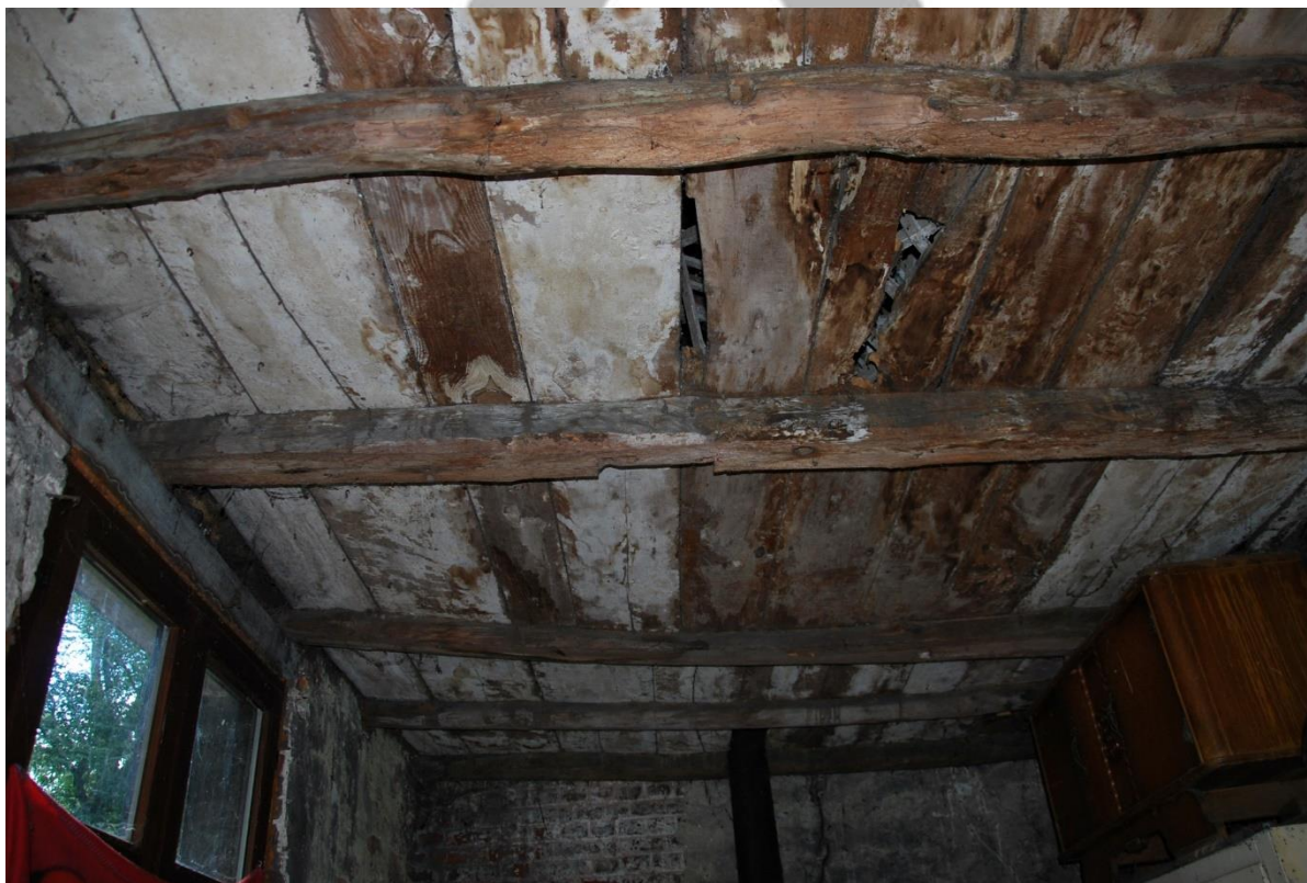
Situering: Koersel I Pastorie. Beschrijving: Interieur I Nivo 0 I Ruimte 0.15. Bron: Architectenburo Erik Martens & Partners I 2019.
