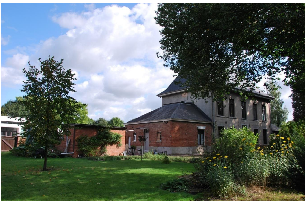
Situering: Koersel | Pastorie. Beschrijving: Extérieur | Zijgevel links (zicht vanaf de tuin). Bron: Architectenburo Erik Martens & Partners | 2019.
