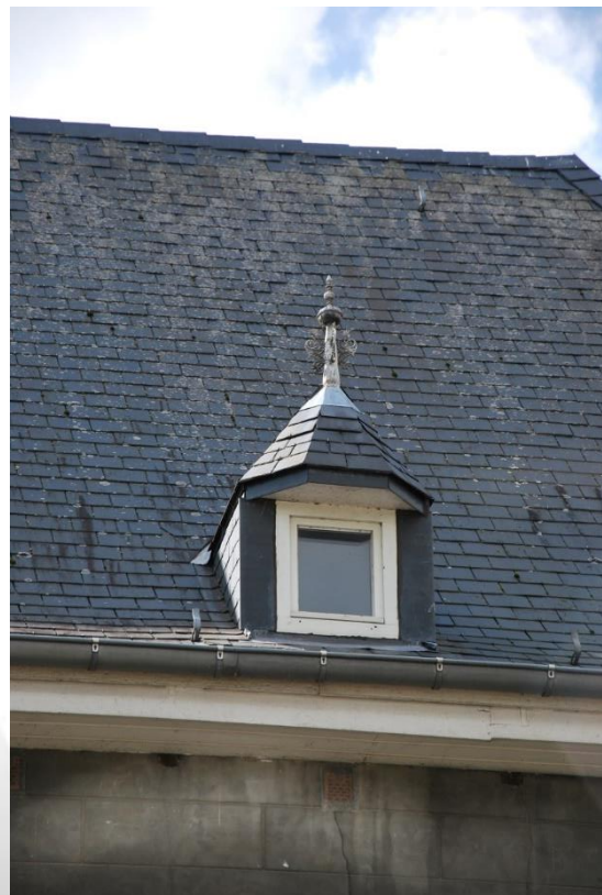
Situering: Koersel I Pastorie. Beschrijving: Extérieur I Voorgevel (detail buitenschrijnwerk). Bron: Architectenburo Erik Martens & Partners I 2019.
