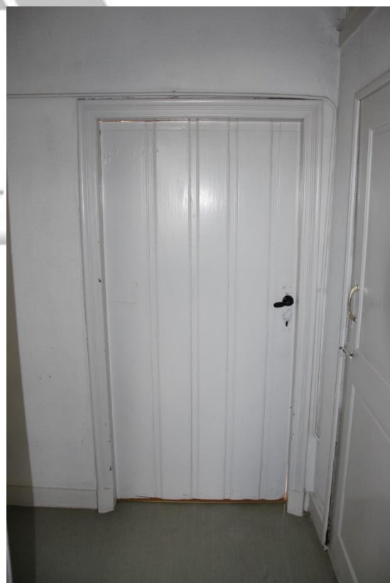
Situering: Koersel I Pastorie. Beschrijving: Interieur I Nivo 1 I Ruimte 1.4. Bron: Architectenburo Erik Martens & Partners I 2019.
