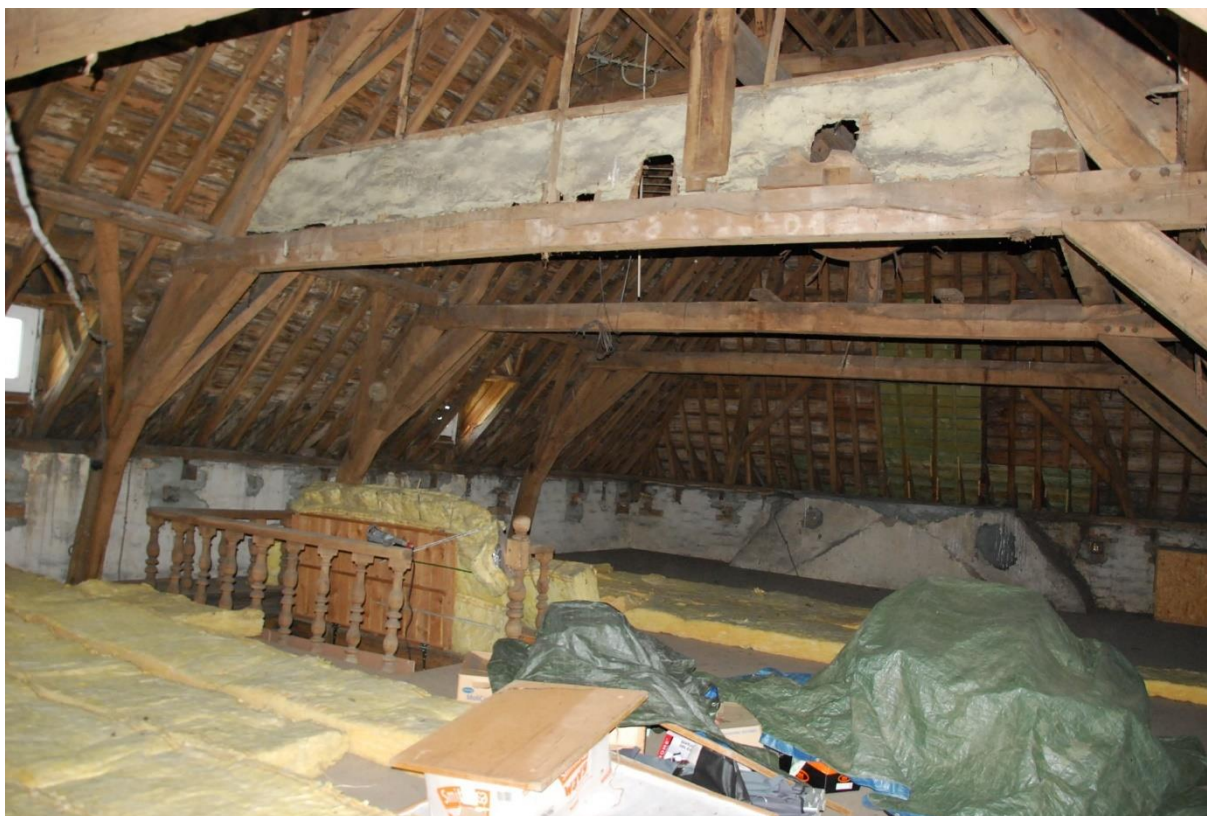
Situering: Koersel | Pastorie. Beschrijving: Interieur | Nivo 2 | Ruimte 2.1. Bron: Architectenburo Erik Martens & Partners | 2019.
