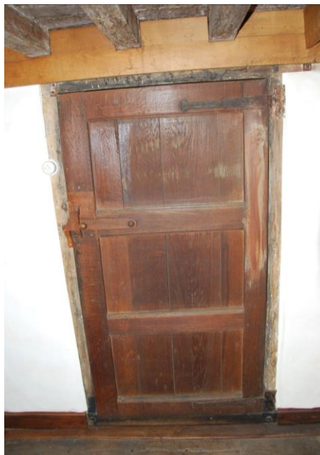
Interieur | Nivo 1,5 | Ruimte 1.9 | Deur naar gang.
