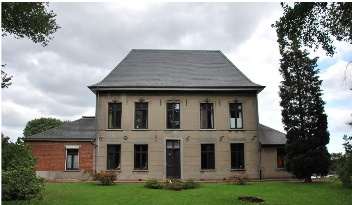
Situering: Koersel I Pastorie. Beschrijving: Extérieur I Voorgevel (zicht vanaf de tuin). Bron: Architectenburo Erik Martens & Partners I 2019.
