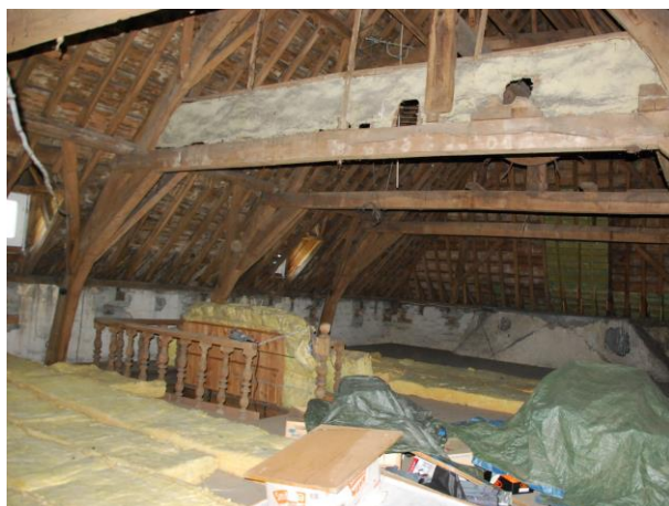
Interieur | Nivo 2 | Ruimte 2.1 | Tienden zolder.
