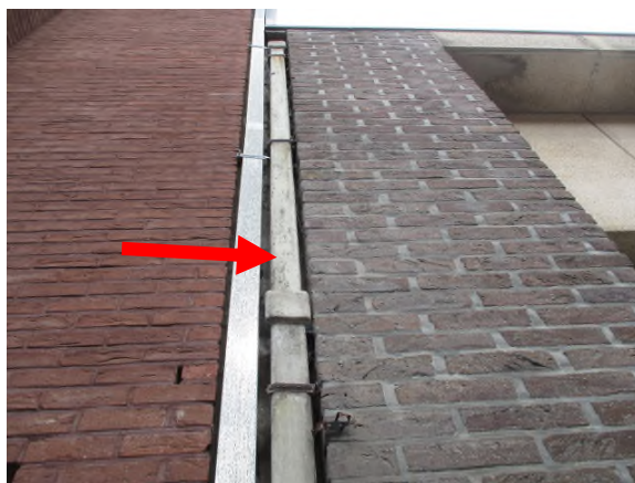
ZM/3: Regenafvoerbuiss in asbestcement
