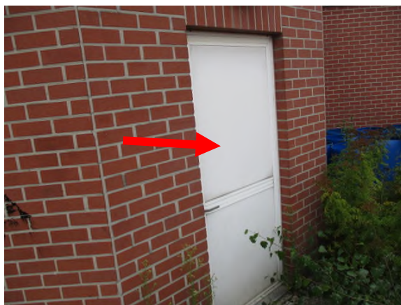
ZM/2: Dubbele platen in asbestcement in deuren
