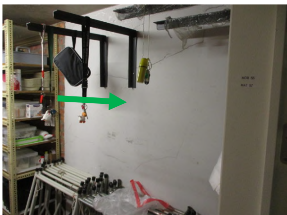
LRK17/2: Pleisterwerk, geen asbest
