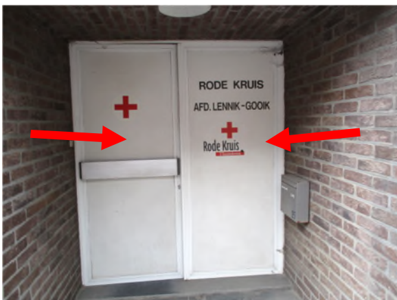
ZM/2: Dubbele platen in asbestcement in deuren
