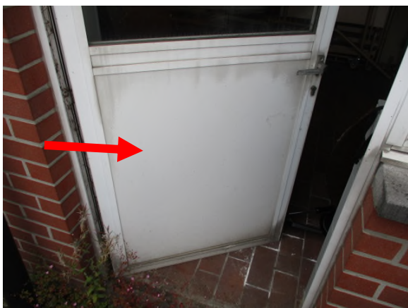
ZM/2: Dubbele platen in asbestcement in deuren
