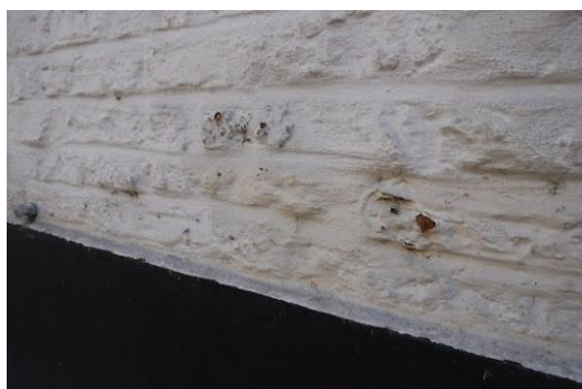
Licht vervuilde en loskomende afwerking.
