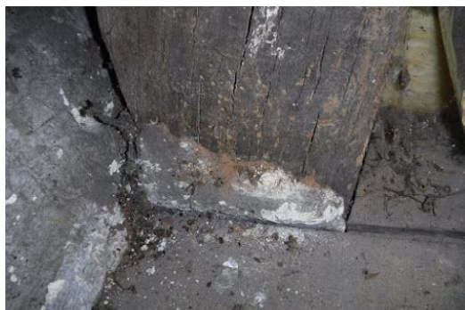
Actief aangetaste spantbeenvoet.
